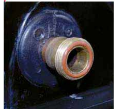
Rechter Kollektoranschluss: Auf korrekten Sitz des O-Rings achten, nicht verkanten
