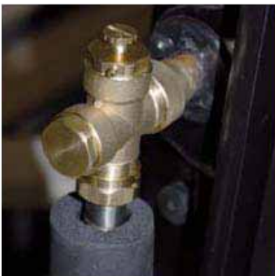
Fertig montiertes T-Stück
