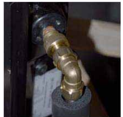
Fertig montierter Anschlusswinkel
