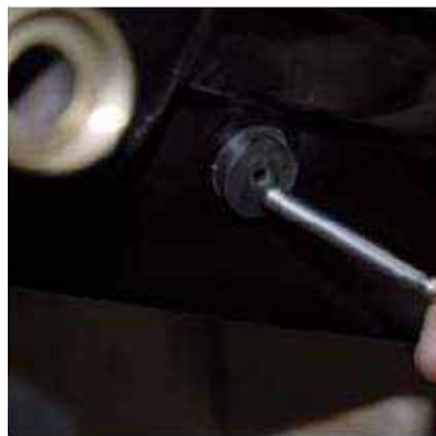
Fühleranschluss (1. Kollektor, Vorlauf)
