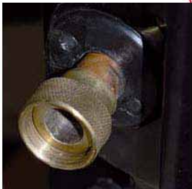
Linker Kollektoranschluss: Mit Überwurfmutter
